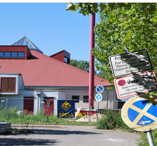
Kosten für die Sanierung des Karbener Hallenbades laufen aus dem Ruder: siehe letzte Seite!
